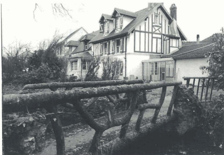
Véranda de la « villa Landolff » (photo P.Canaff 1985)
