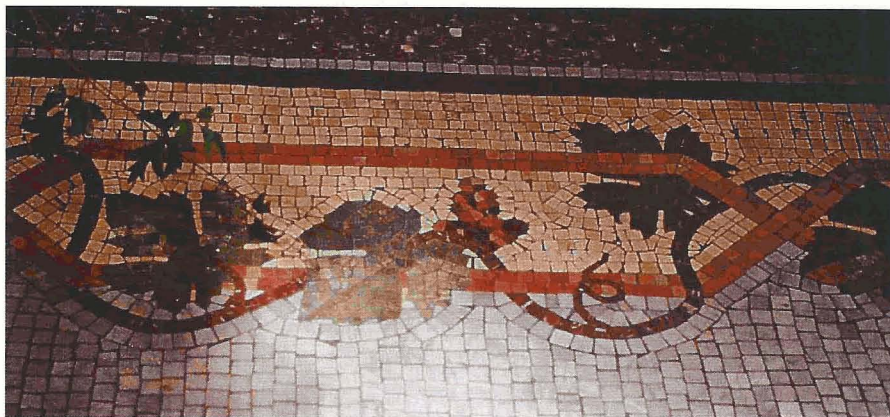
Détail du sol du vestibule (photo G.Sandras, 2004)
