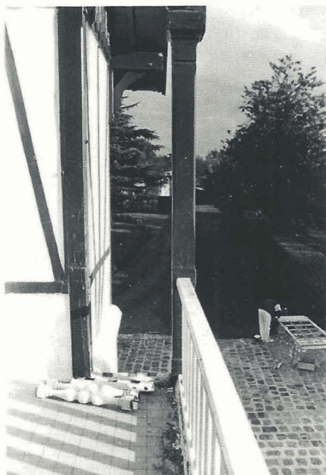
Balustrade en cours de restauration (photo EAN)
