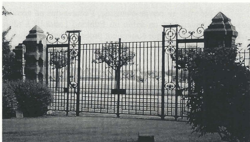
Vue intérieure de l'entrée principale (photo J.Guermeur)
