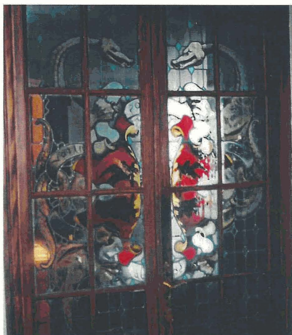
Porte-fenêtre de la salle à manger (photo BAN)
