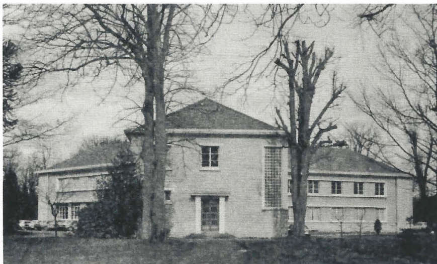
Le bâtiment « Y » (photo BAN 1982)
